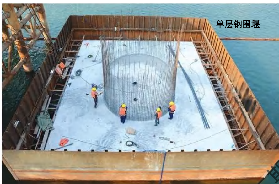
图 2.5-6 钢围堰典型施工图
