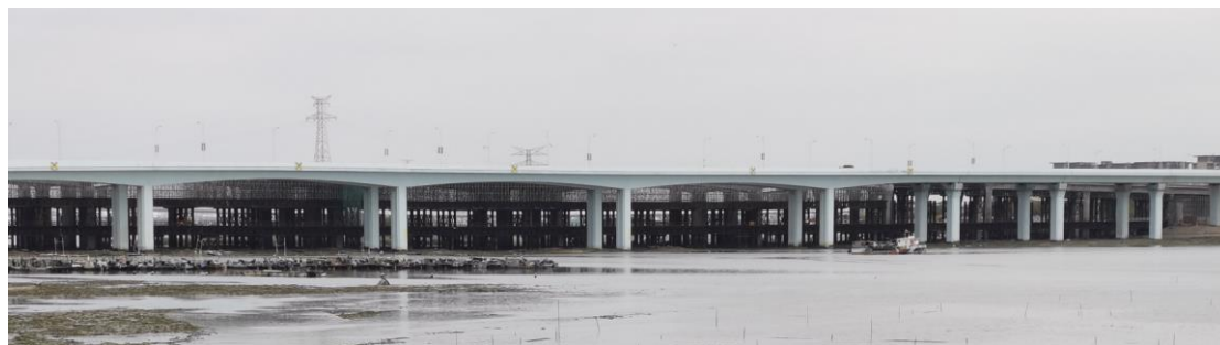
图 2.6-2 厦门市轨道交通 3 号、4 号线工程大嶝过海段工程（跨海桥梁）
