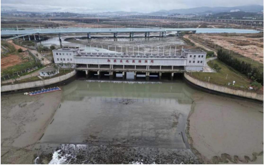
图 2.6-4 九溪河挡潮闸
